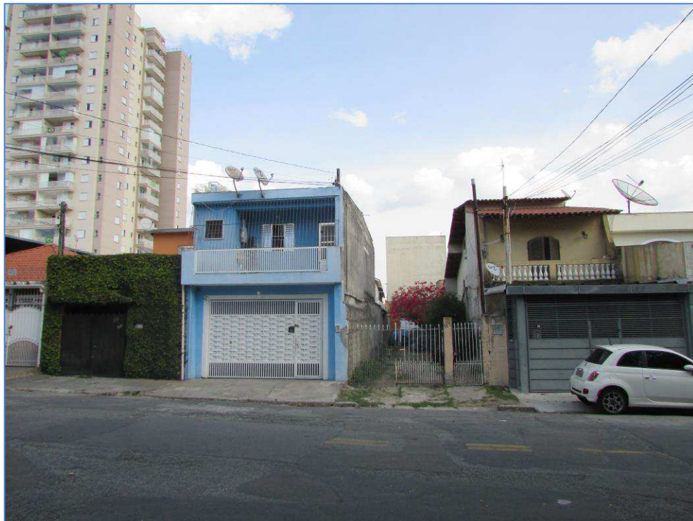
FACHADA DO IMÓVEL AVALIANDO.
