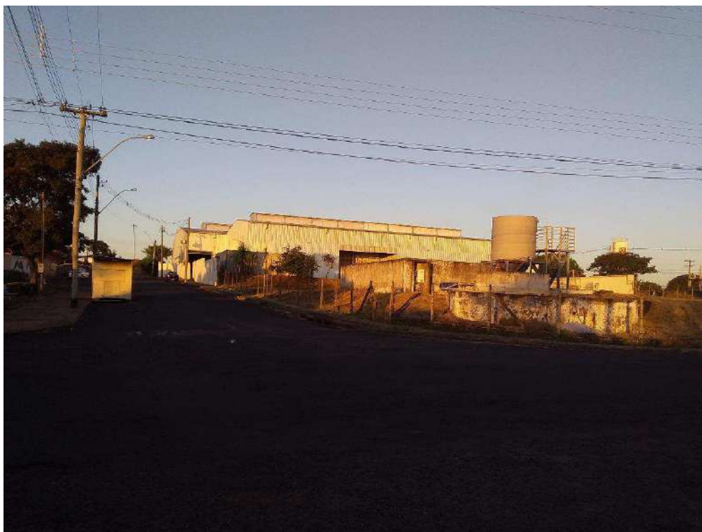
1- Vista externa do imóvel
