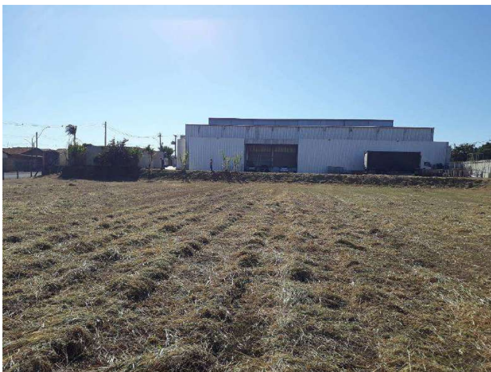
4- Área externa – vista da Fábrica
