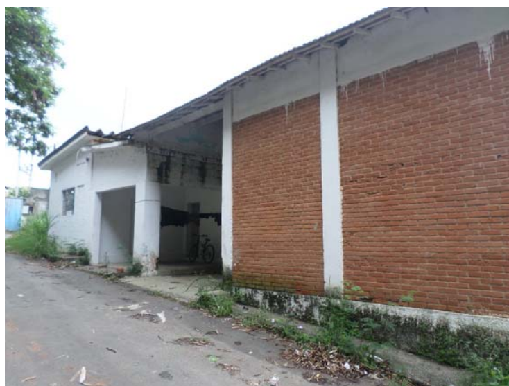
Fotografia 06 – Aspecto das construções existentes (Galpão 01).
