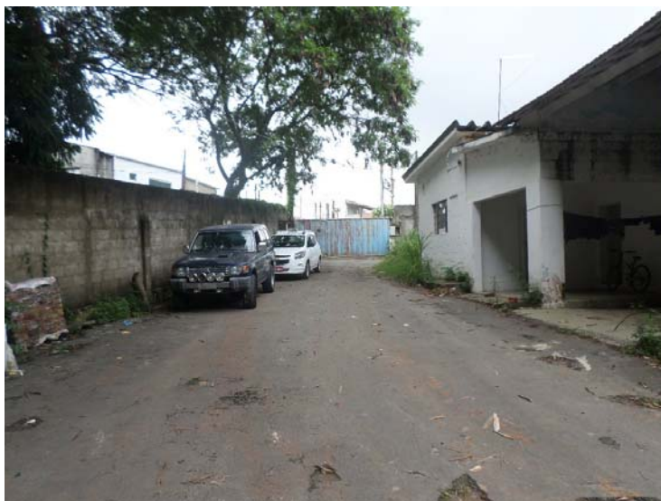
Fotografia 12 – Aspecto geral do imóvel avaliado.
