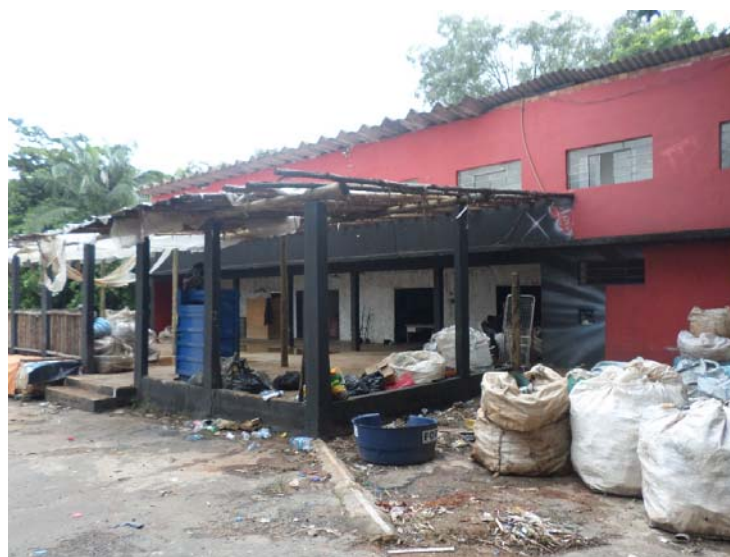
Fotografia 09 – Aspecto das construções existentes (Edificação 03).
