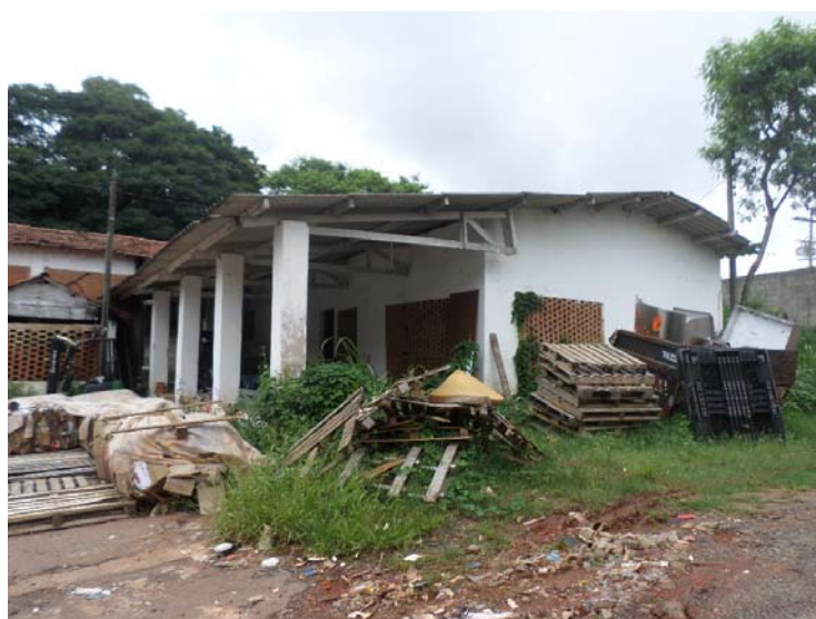
Fotografia 07 – Aspecto das construções existentes (Galpão 01).
