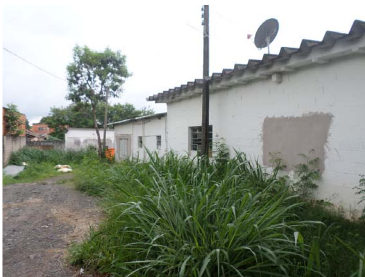
Fotografia 11 – Aspecto geral do imóvel avaliado.
