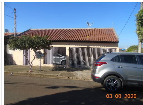
Imagem 01. Vista da garagem
