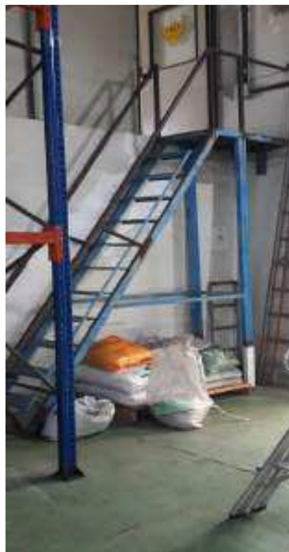
22. ESCADA DE FERRO
