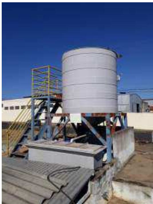
02. CENTRAL DE TRATAMENTO DE EFLUENTES COM TANQUE PVC 5.000 LTS, CAIXA DE RESÍDUOS, BOMBA SUBMERSA E ESTRUTURA METÁLICA
