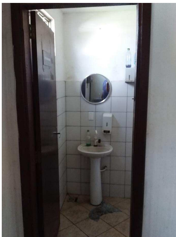
12- Banheiro masculino entrada
