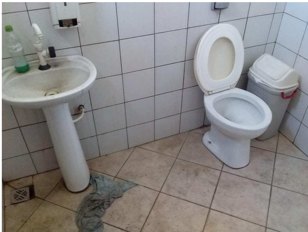
13- Banheiro masculino interno
