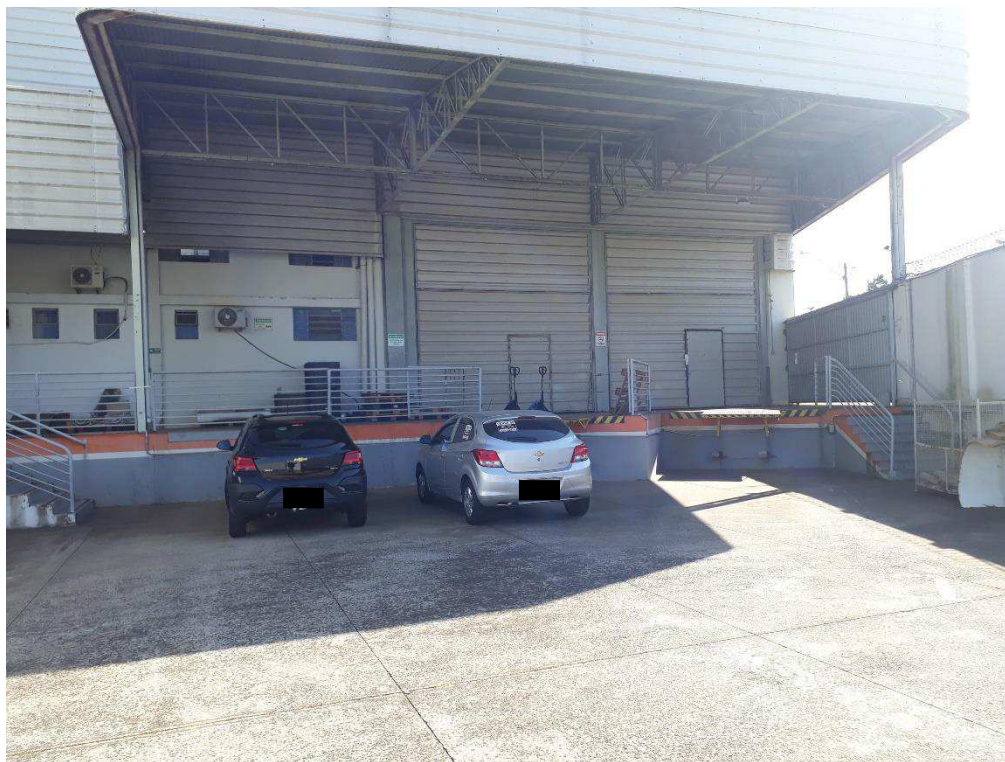
5- Pátio de entrada – Acesso carga e descarga de materiais
