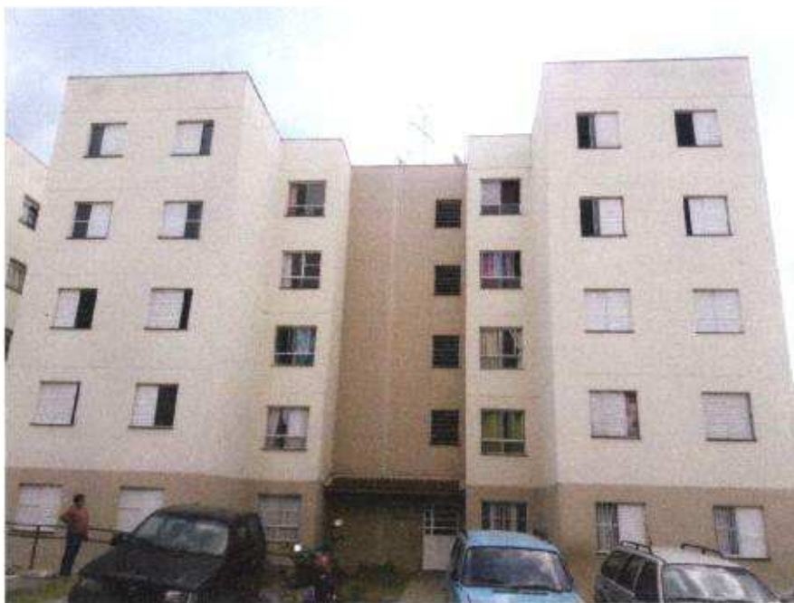
3- Torre 3 – alvo da vistoria
