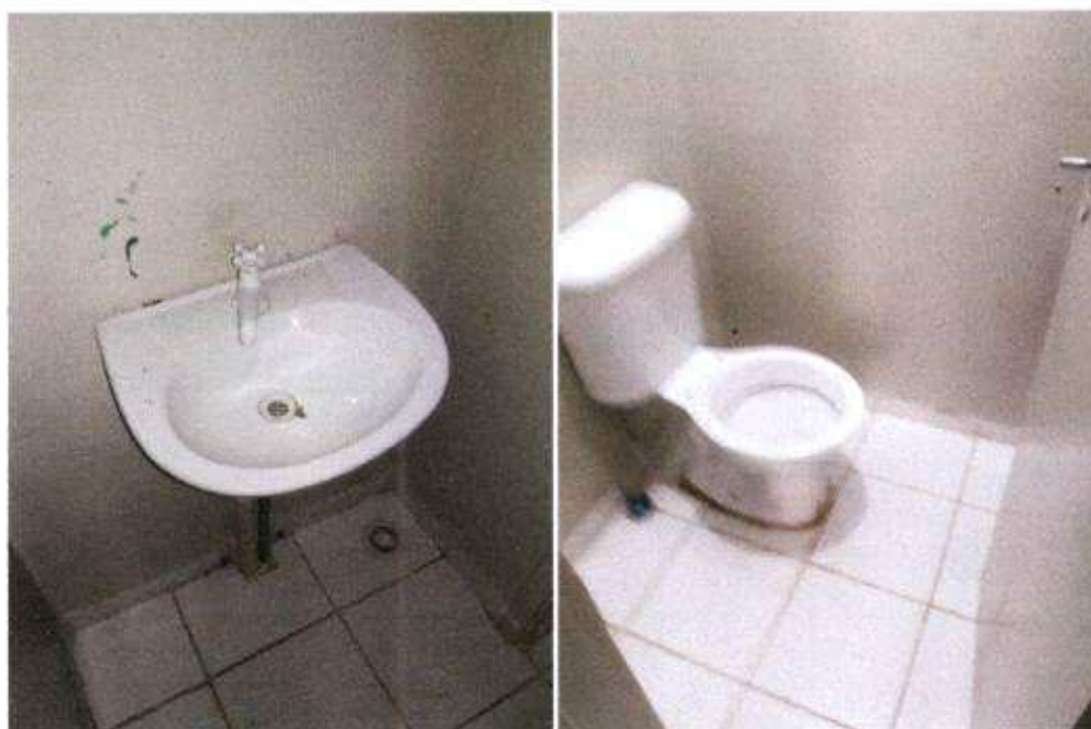
15- Banheiro Salão de eventos
