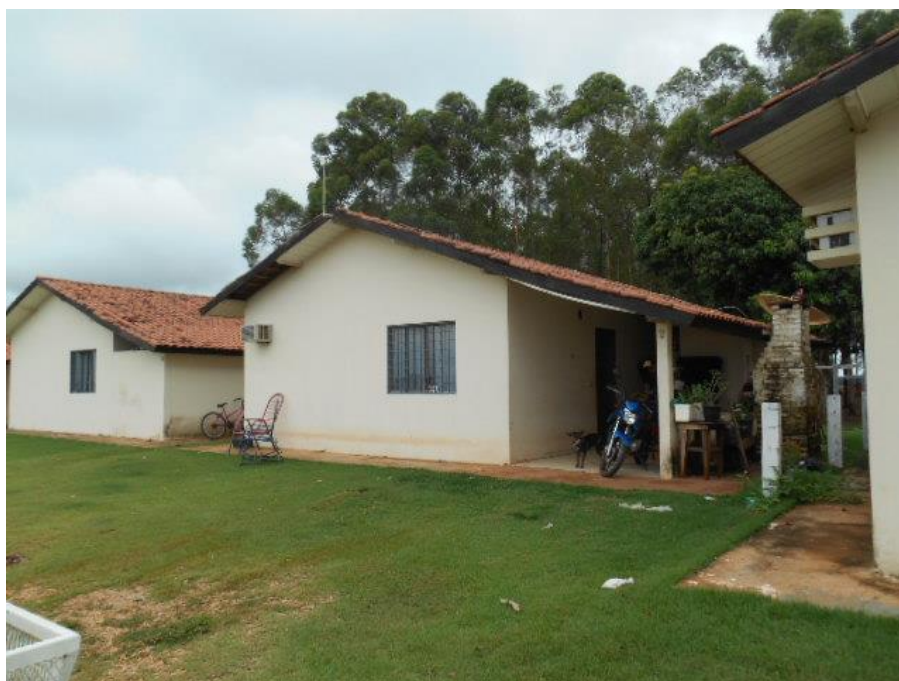
FOTO Nº 15: Vista da residência 2.
