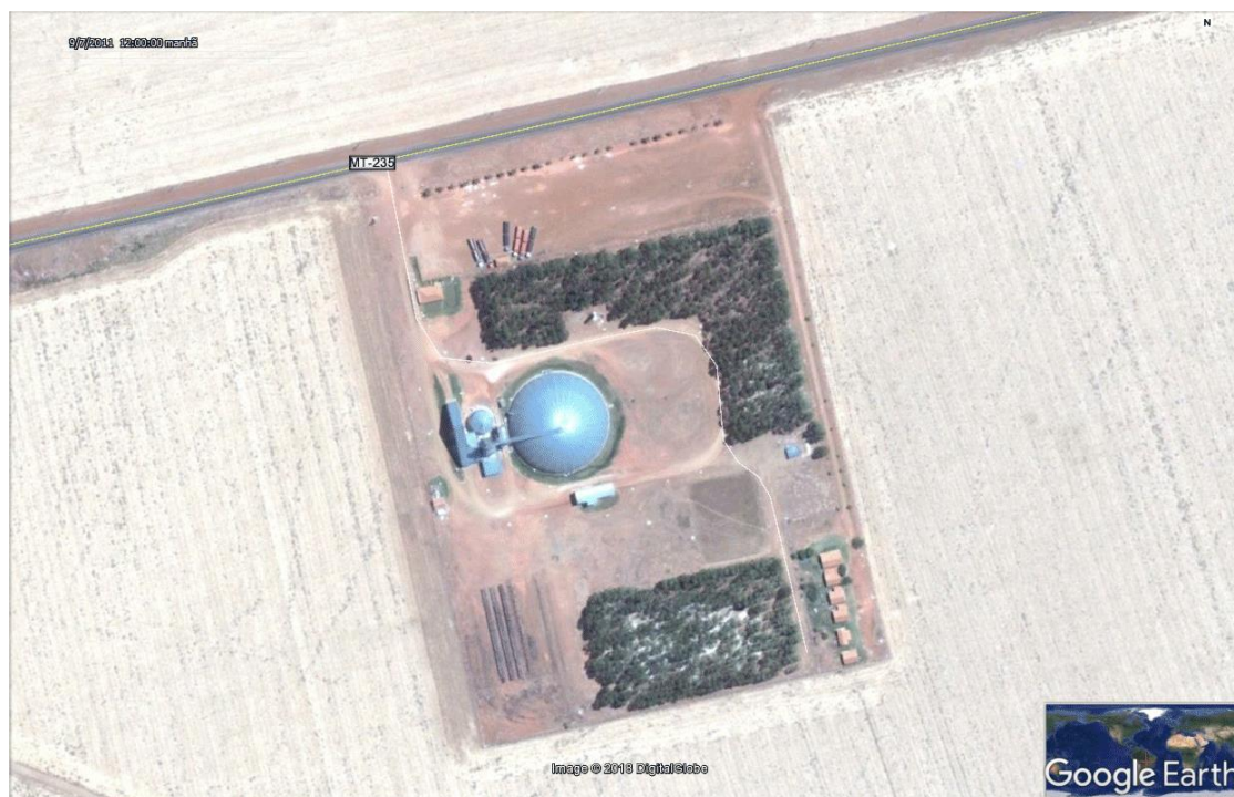
Vista do imóvel.
