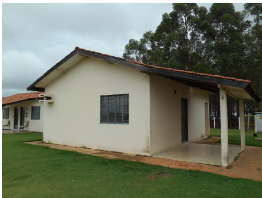
FOTO Nº 17: Vista da residência 4.
