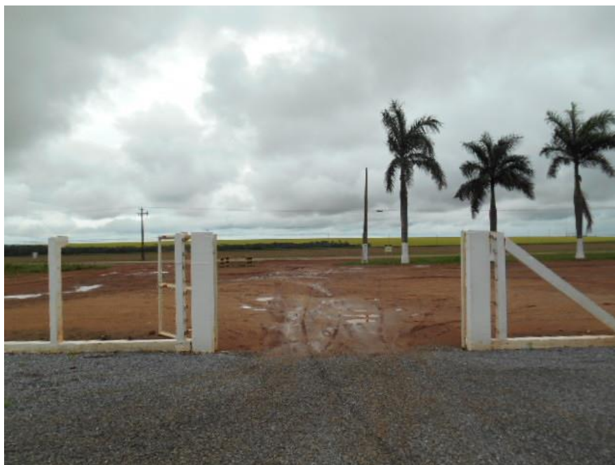
FOTO Nº 02: Vista da Entrada do imóvel junto a Rod. MT-235.
