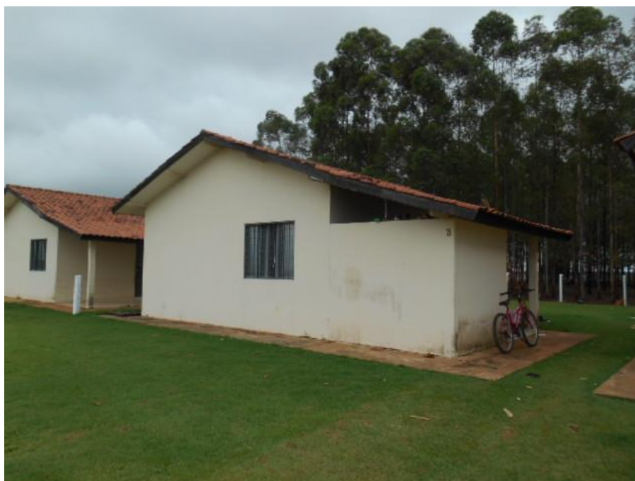
FOTO Nº 16: Vista da residência 3.
