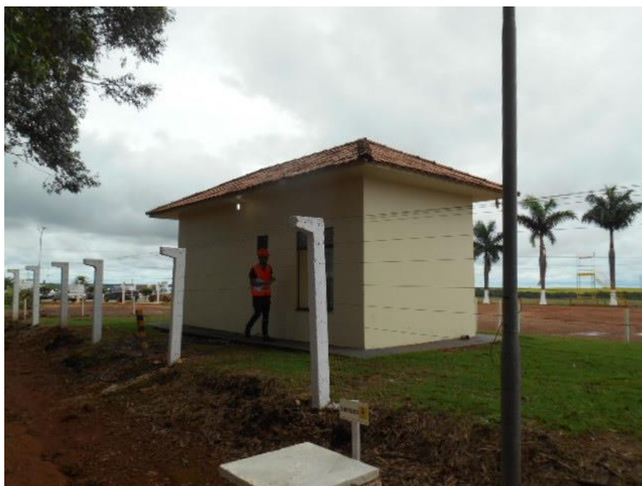
FOTO Nº 18: Vista do alojamento.
