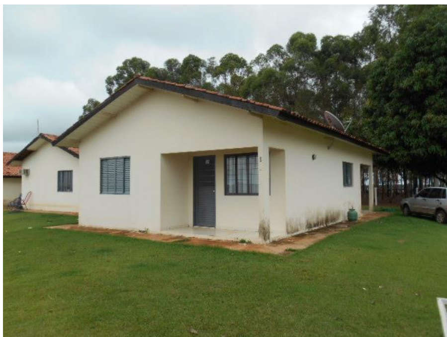
FOTO Nº 14: Vista da residência 1.
