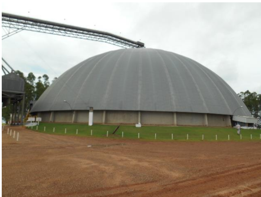
FOTO Nº 10: Vista do silo graneleiro.
