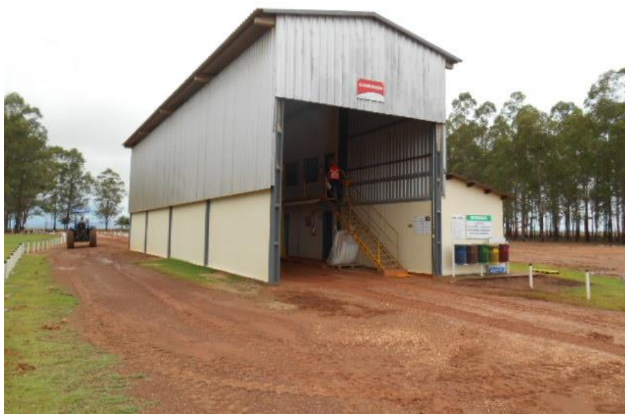
FOTO Nº 08: Vista do Galpão Classificação.
