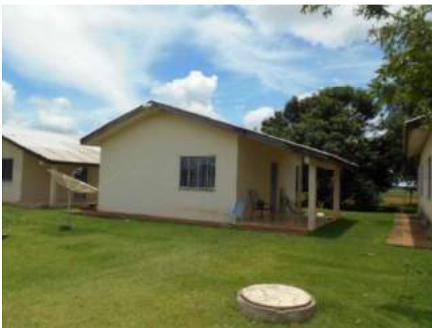
FOTO Nº 16: Vista da residência 3.
