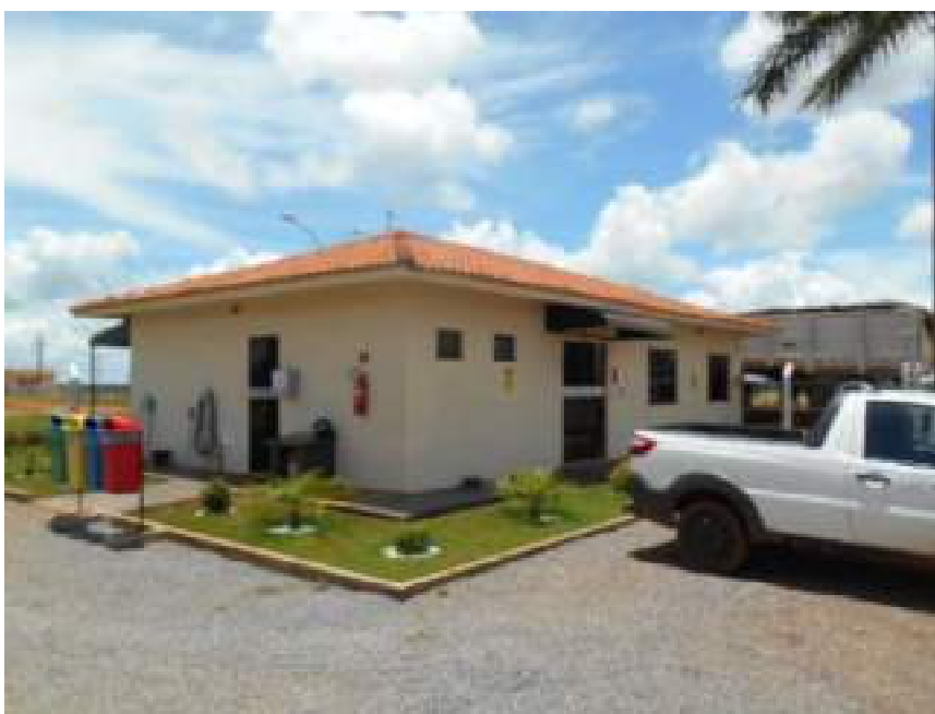
FOTO Nº 05: Vista do escritório.
