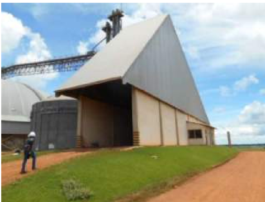
FOTO Nº 11: Vista da moega.
