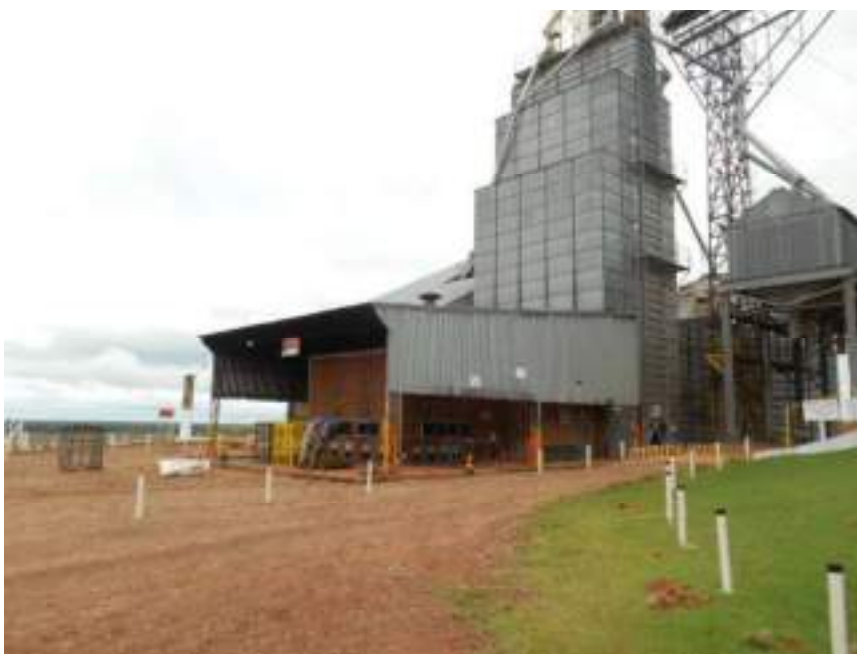
FOTO Nº 12: Vista da fomalha.
