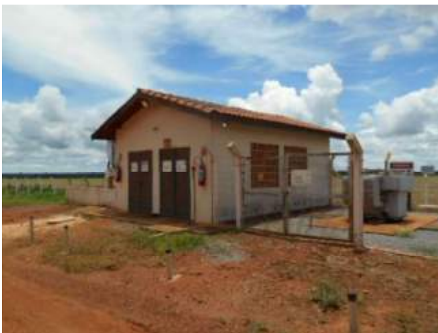
FOTO Nº 09: Vista da Casa do Gerador.
