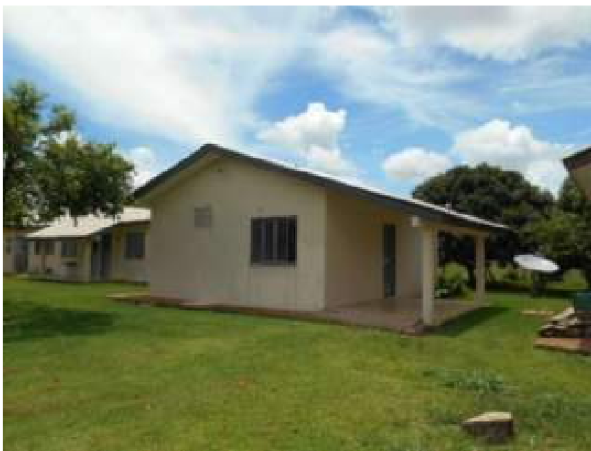
FOTO Nº 17: Vista da residência 4.
