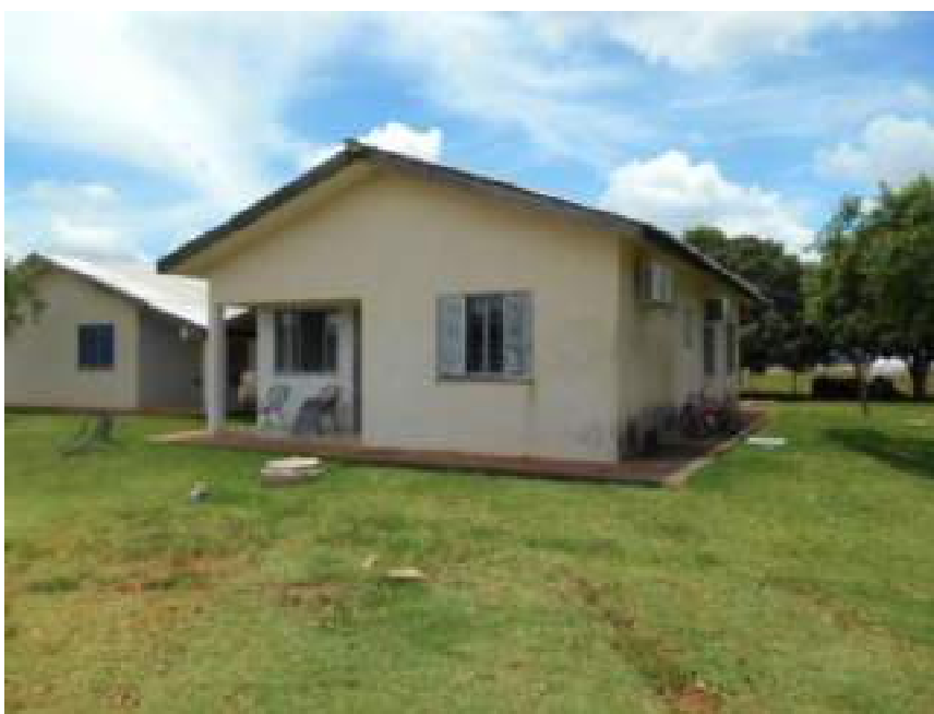
FOTO Nº 14: Vista da residência 1.
