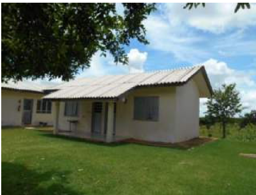
FOTO Nº 13: Vista da residência de motoristas.
