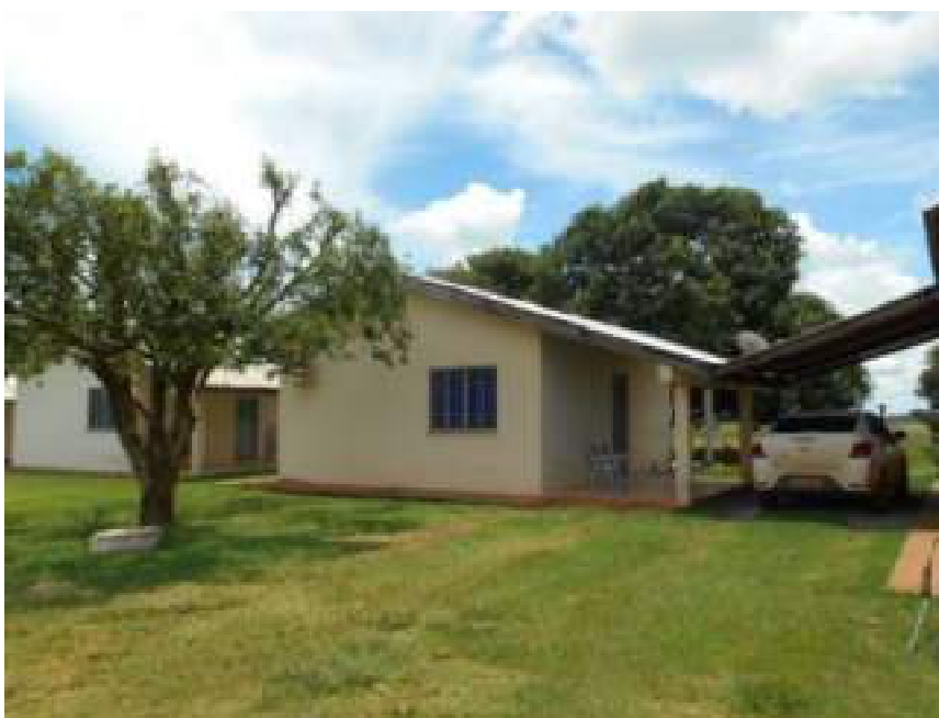
FOTO Nº 15: Vista da residência 2.
