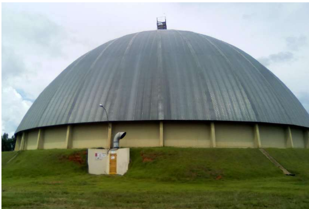
FOTO Nº 10: Vista do silo graneleiro.
