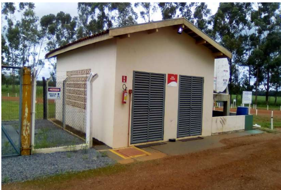
FOTO Nº 09: Vista da Casa do Gerador.
