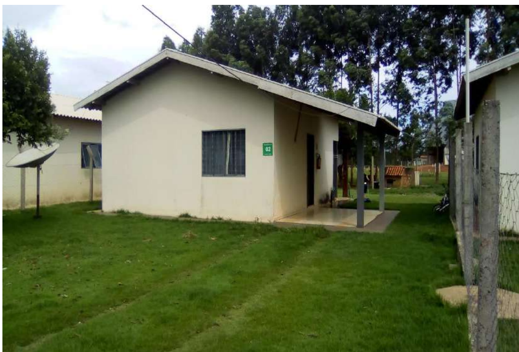
FOTO Nº 15: Vista da residência 2.
