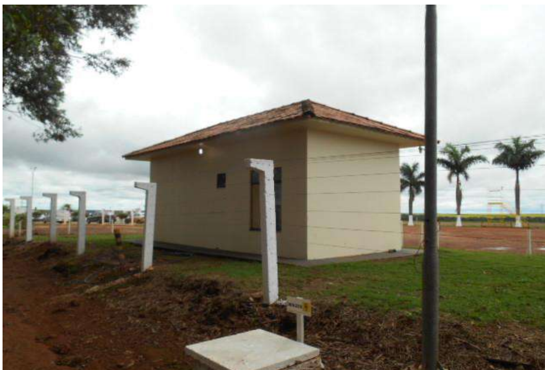
FOTO Nº 18: Vista do alojamento.
