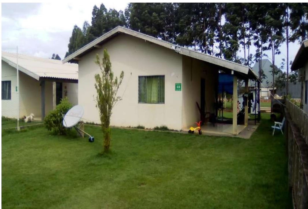
FOTO Nº 16: Vista da residência 3.
