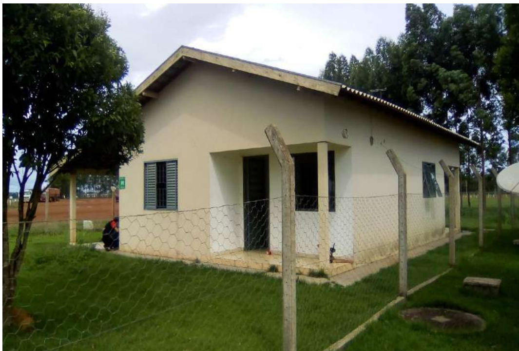
FOTO Nº 14: Vista da residência 1.
