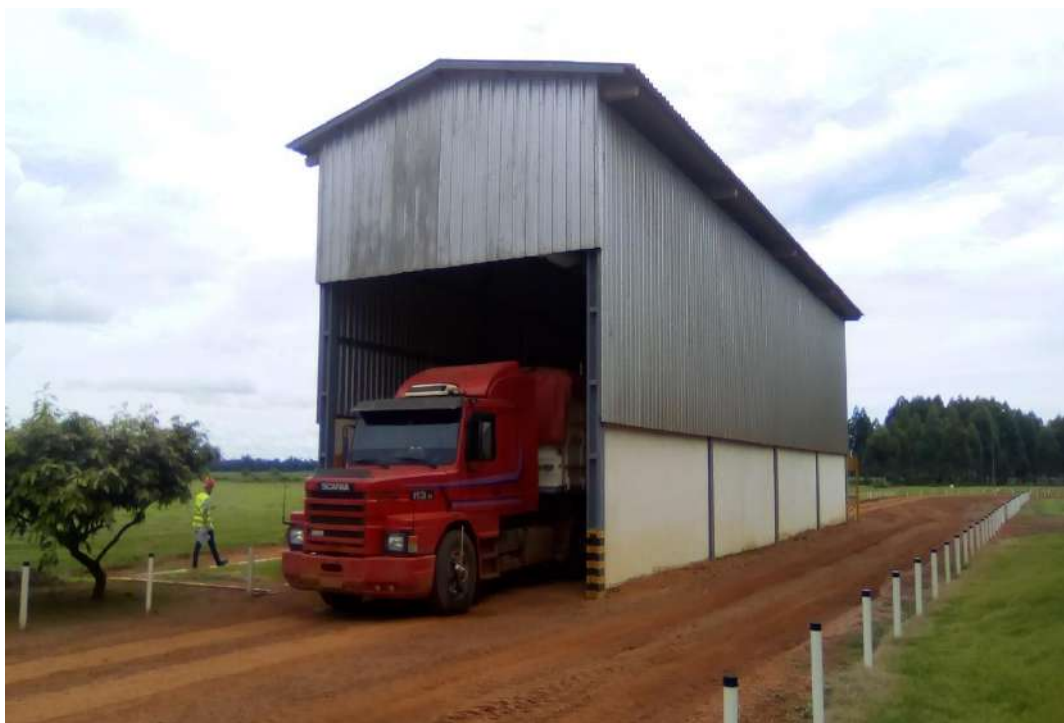
FOTO Nº 08: Vista do Galpão Classificação.
