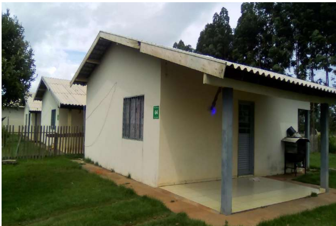
FOTO Nº 17: Vista da residência 4.
