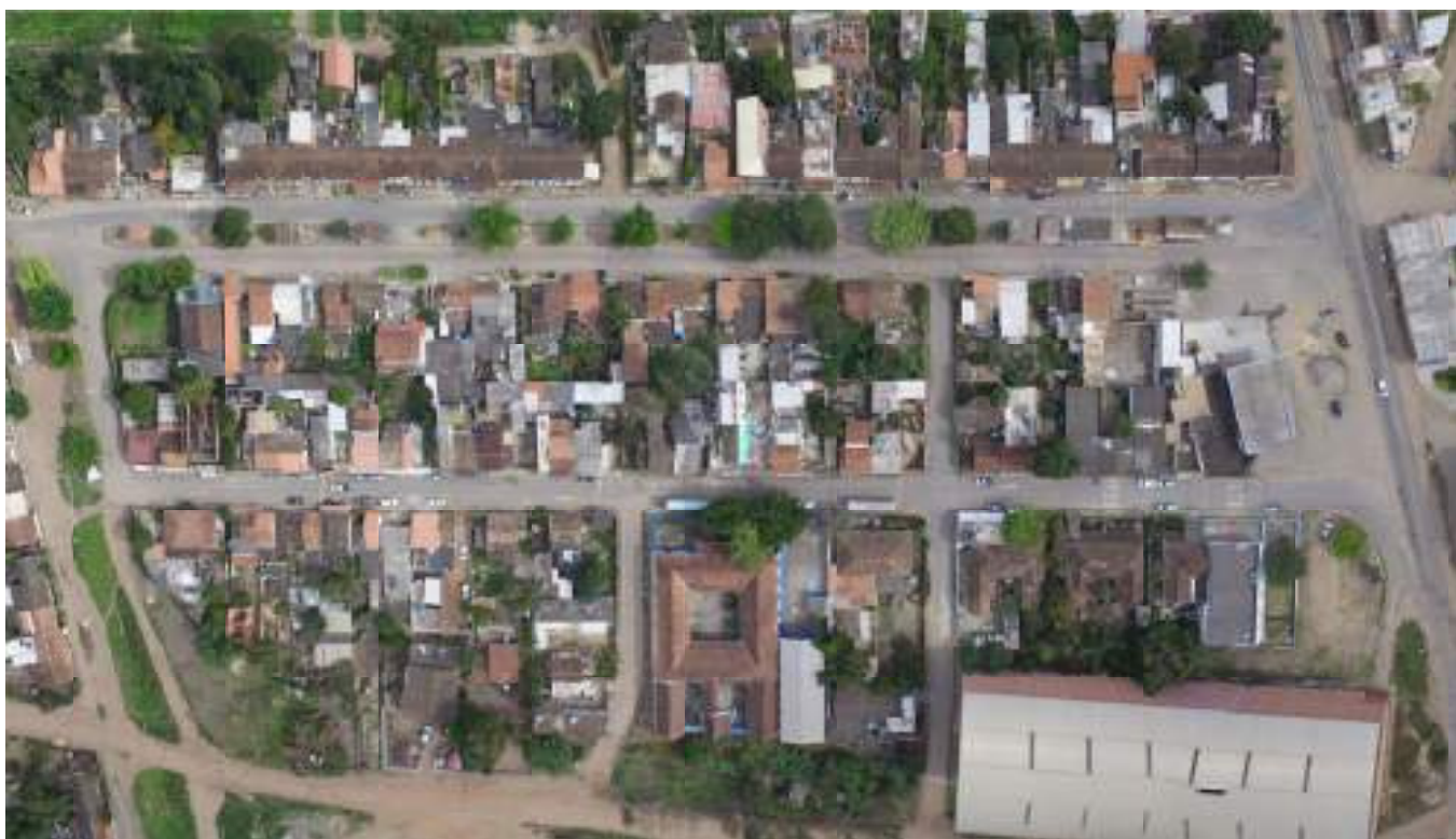
Fotografia 05 – Aspecto geral das ocupações das Glebas A, B, C, D, E e F da Área 01 do Bairro da Santa Cruz.
