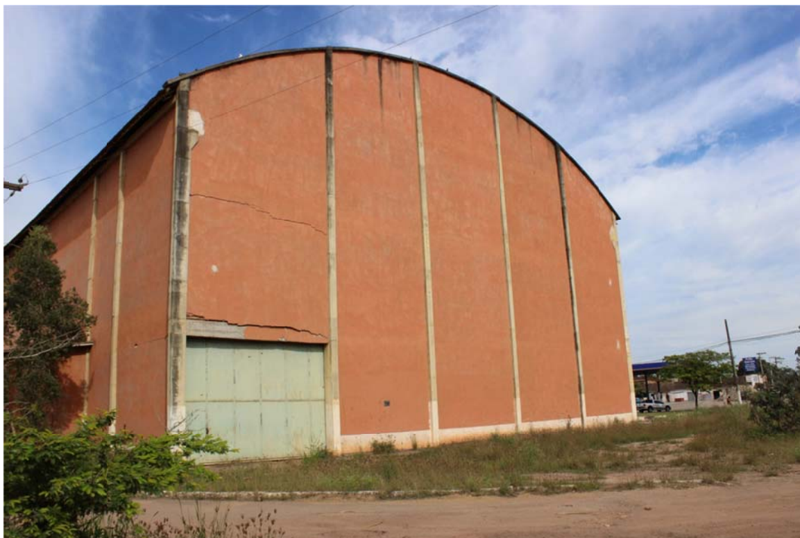
Fotografia 06 – Outro aspecto externo do imóvel avaliado junto à Travessa Independência e Rodovia RJ 158.
