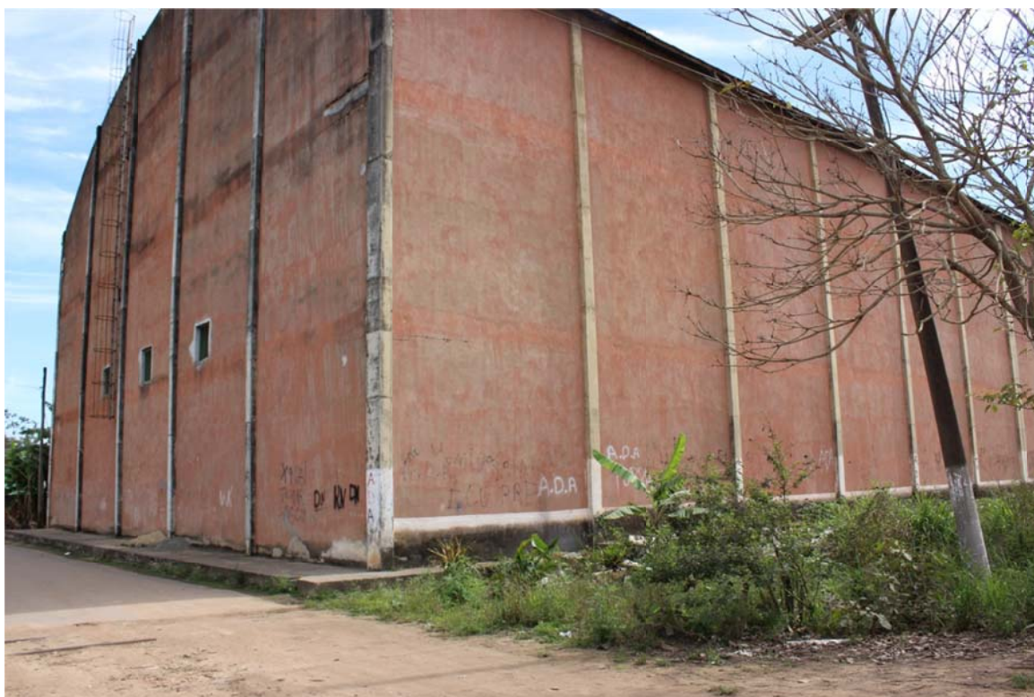
Fotografia 08 – Outro dos fundos da área externa do imóvel avaliado.
