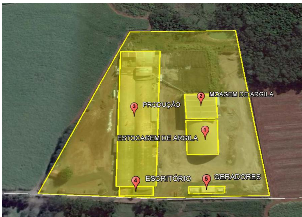
Localização do Imóvel avaliado (em amarelo) e os setores específicos da planta industrial avaliada:
