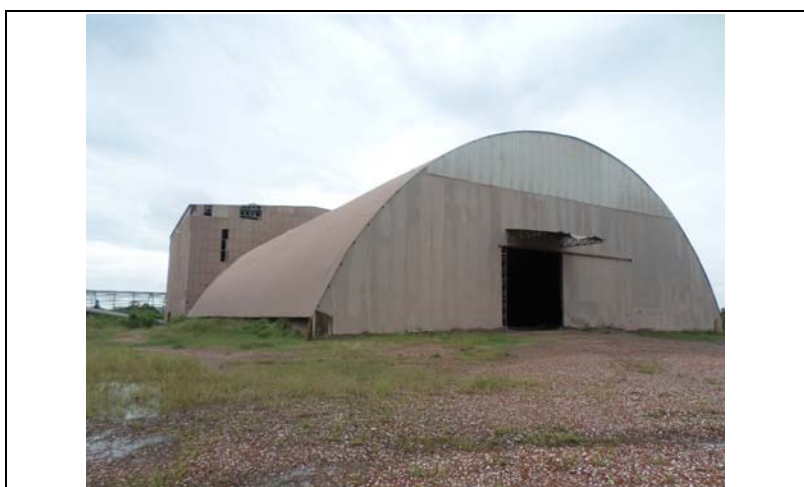
Fotografia 01 – Vista externa do Setor de Estocagem.
