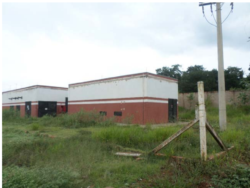
Fotografia 09 – Aspecto externo das edificações do setor de geradores.
