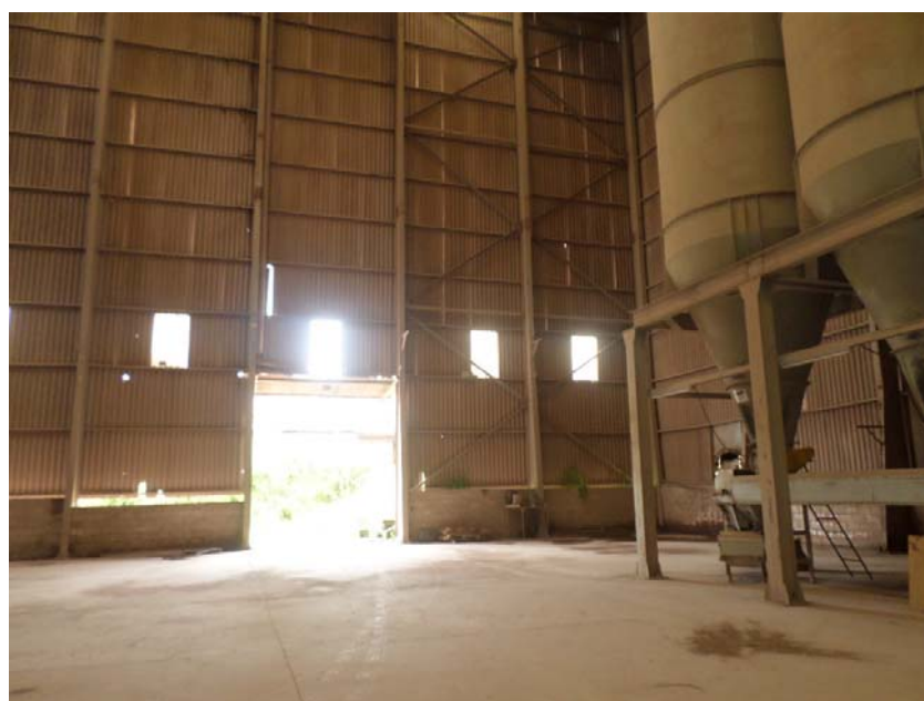
Fotografia 18 – Aspecto interno do galpão de moagem de argila.
