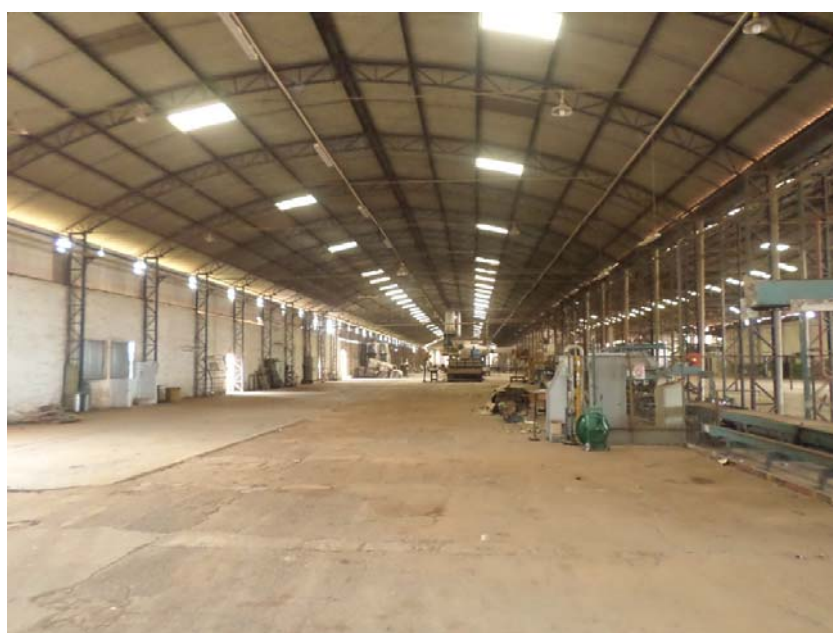
Fotografia 16 – Aspecto interno do galpão de produção.
