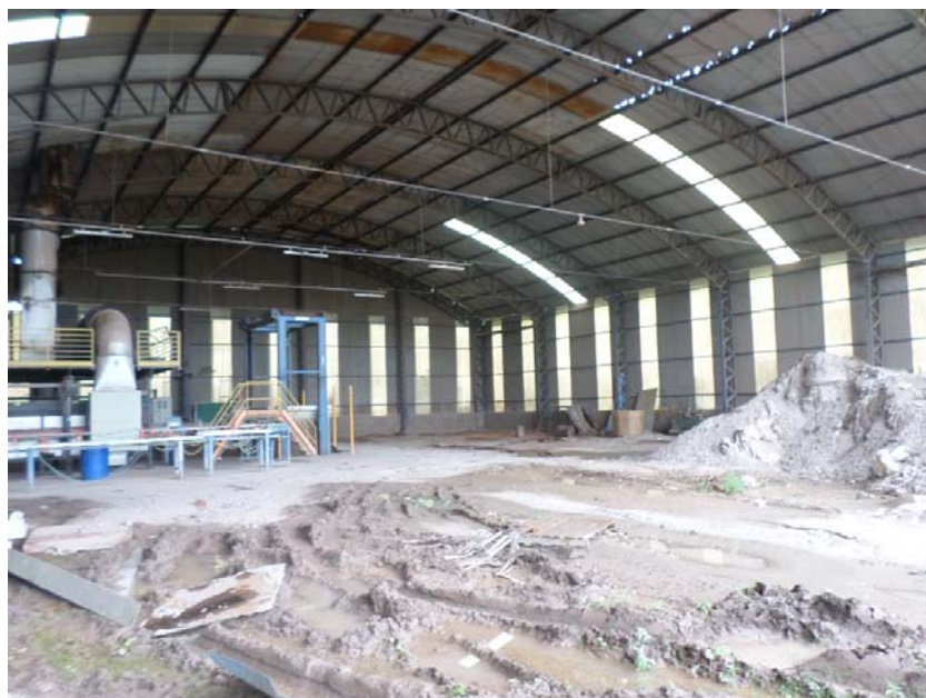
Fotografia 13 – Aspecto interno do galpão de produção.
