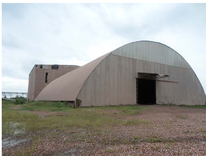
Fotografia 10 – Aspecto externo do galpão de estocagem de argila.
