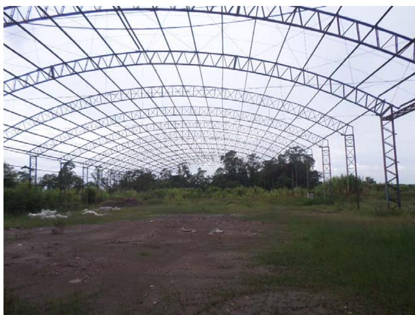
Fotografia 14 – Aspecto da estrutura junto ao galpão de produção.
