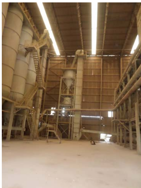
Fotografia 19 – Aspecto interno do galpão de moagem de argila.
