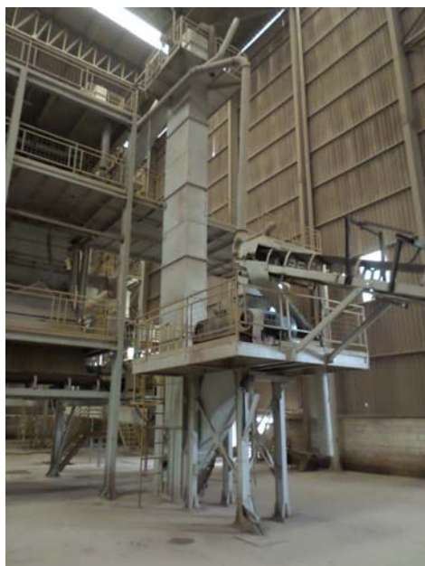
Fotografia 17 – Aspecto interno do galpão de moagem de argila.
