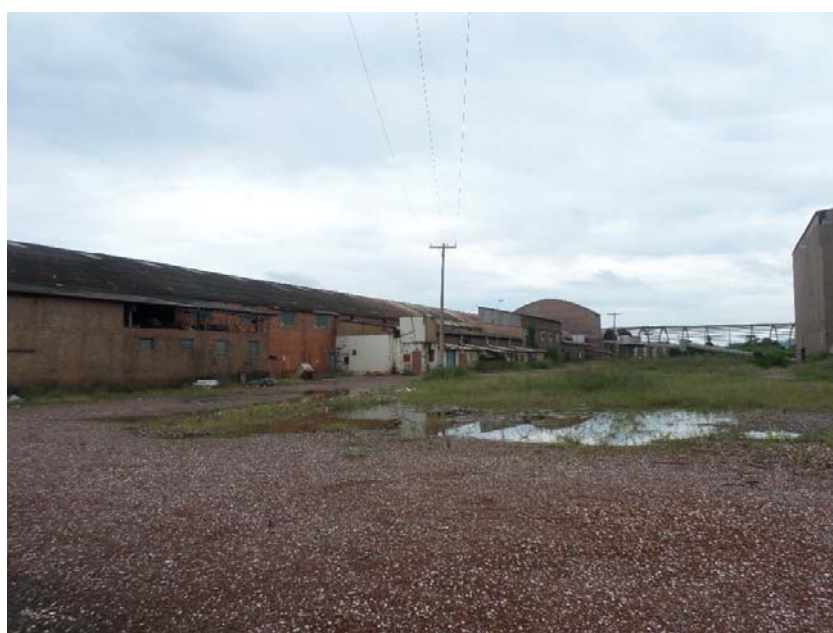
Fotografia 08 – Aspecto externo do galpão de produção.
