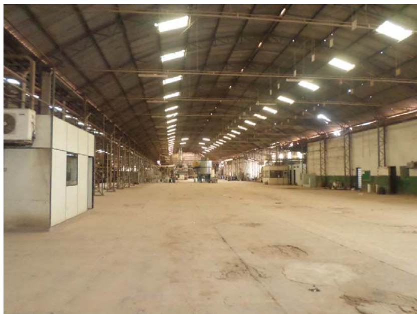
Fotografia 15 – Aspecto interno do galpão de produção.
