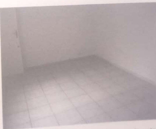
Foto 32 – Aspectos de uma unidade no pavimento superior.
