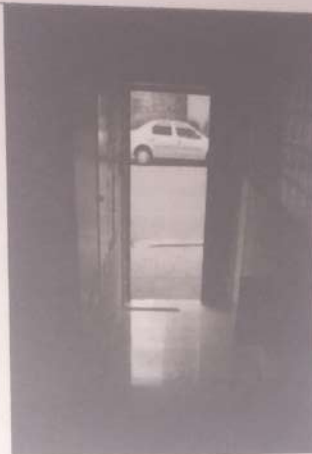
Foto 30 – Entrada no térreo.
