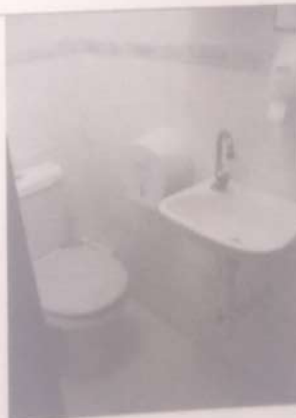
Foto 28 – Banheiro no térreo.
