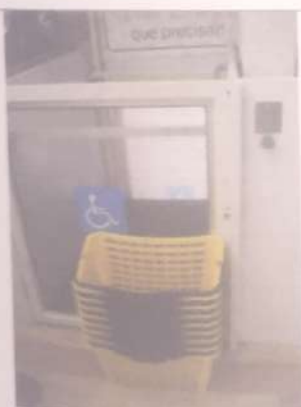
Foto 11 - Elevador para deficiente.
