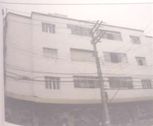
Foto 07 – Aspectos da fachada.
