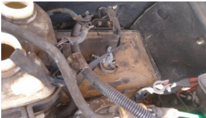
Foto Avaria Bateria
