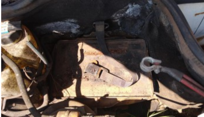
Foto Avaria Bateria
