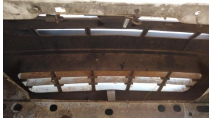
Detalhe da Avaria
