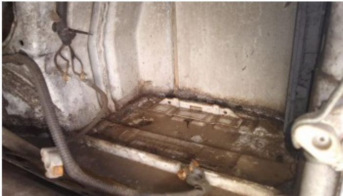
Foto Avaria Bateria
