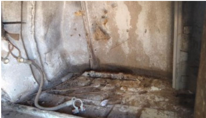
Foto Avaria Bateria
