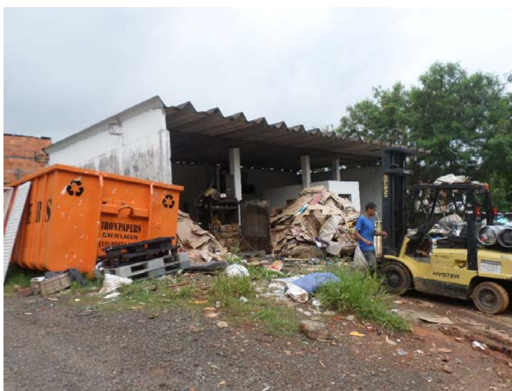
Fotografia 08 – Aspecto das construções existentes (Galpão 02).
