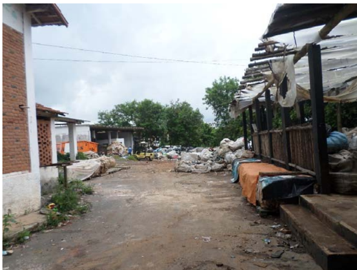
Fotografia 10 – Aspecto geral do imóvel avaliado.
