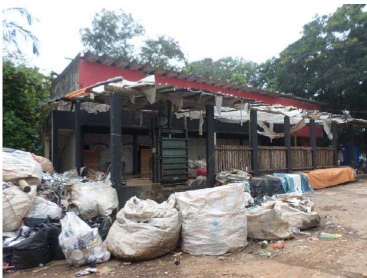
Fotografia 13 – Aspecto geral do imóvel avaliado.
