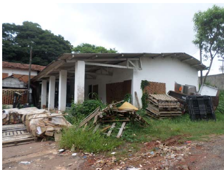
Fotografia 07 – Aspecto das construções existentes (Galpão 01).
