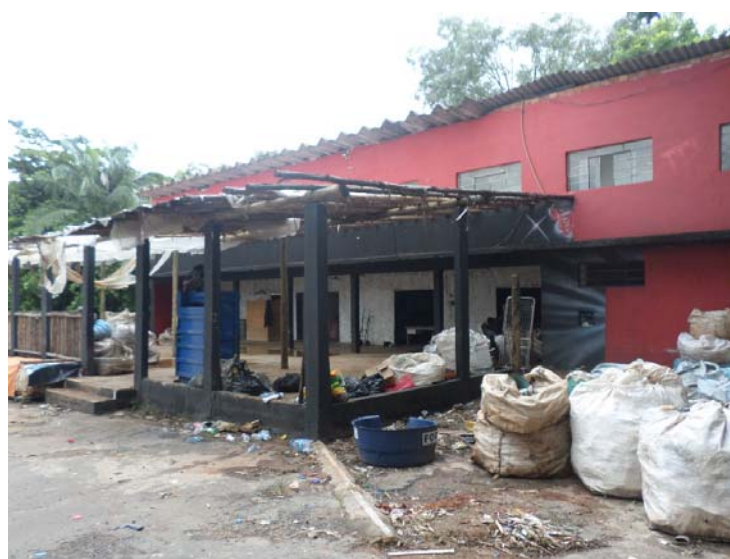
Fotografia 09 – Aspecto das construções existentes (Edificação 03).
