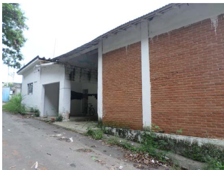
Fotografia 06 – Aspecto das construções existentes (Galpão 01).
